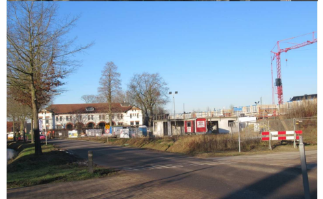
6 Nieuwbouw bij het Witte Huis te Zetten
