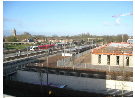
10 Station Elst met polikliniek Rijnstate in aanbouw
